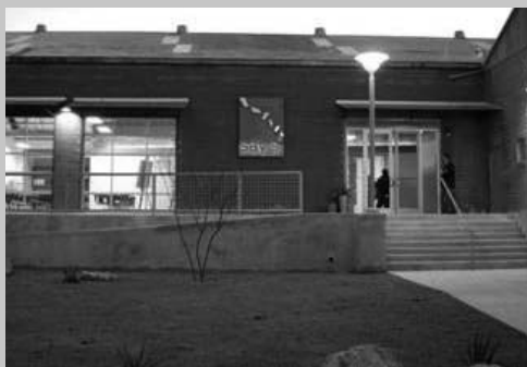
Say Sí Central exterior view
